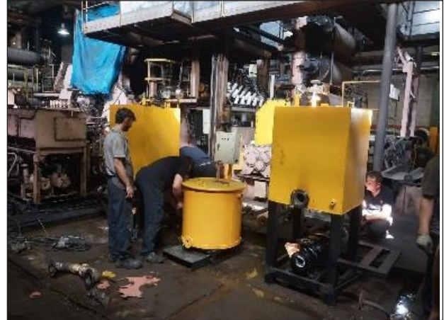
شکل ۳- نصب و راه اندازی سیستم TCU جدید
