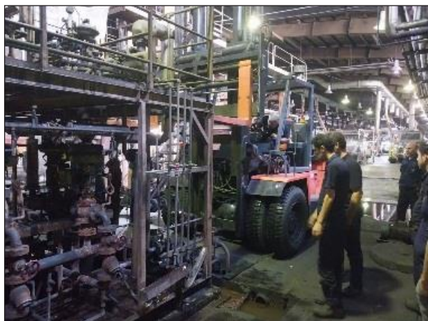
شکل ۲- دمونتاز و انتقال سیستم TCU قدیمی
